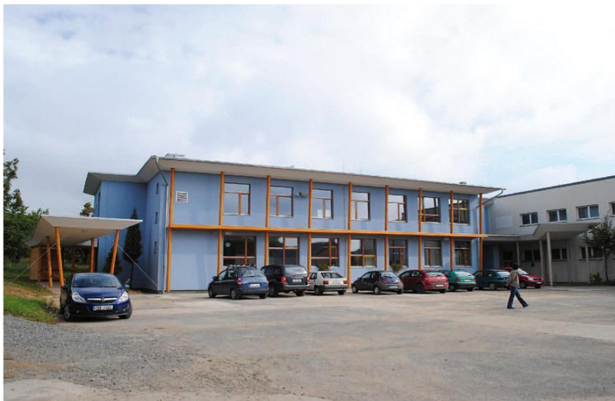
Při rekonstrukci základní školy v pražském Slivenci byl kladen důraz nejen na úspory, ale i kvalitu vnitřního prostředí. Autor domu: Akad. arch. Aleš Brotánek
