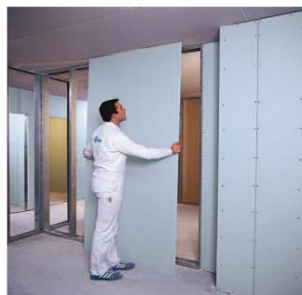
Montáž modré akustické sádrokartonové příčky Rigips
