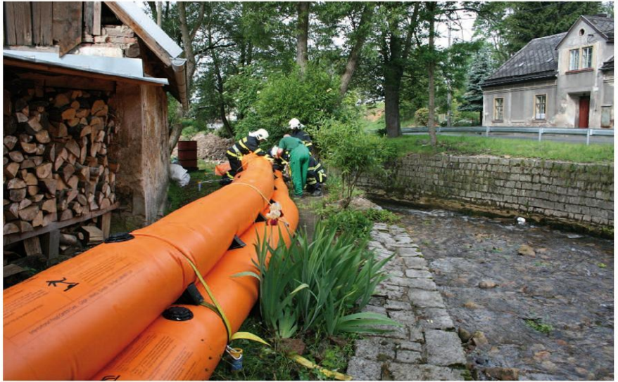
„Kdyby to takhle fungovalo při povodni, voda se nám vůbec nedostala do domu,“ pochvaloval si při návštěvě stavby mobilních protipovodňových hrází Tiger Dam majitel jedné z nemovitostí v Nové Vsi na Liberecku Petr Kučera.
