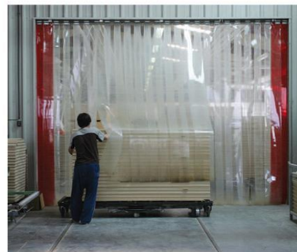
Správně zvolená a odborně instalovaná protiprůvanová clona je schopna zadržet až 80 % ztrátové tepelné energie.
