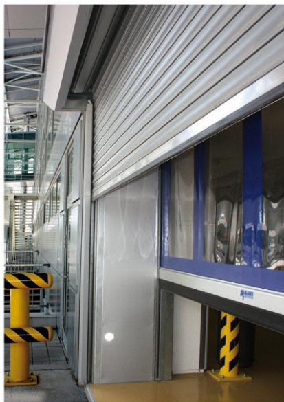
Správně zvolená a odborně instalovaná protiprůvanová clona je schopna zadržet až 80 % ztrátové tepelné energie.
