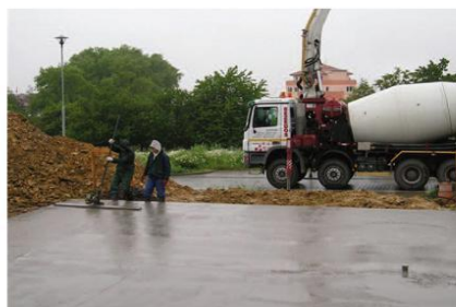
Deska s přísadou Xypex Admix krátce po betonáži
