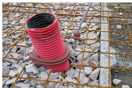
Prostup ošetřený bentonitovým páskem
