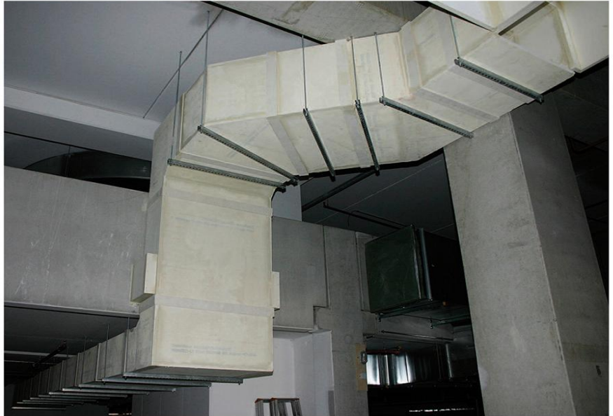
Příklad potrubí pro odvod kouře a tepla PROMATECT® – L 500, EI multi 30
