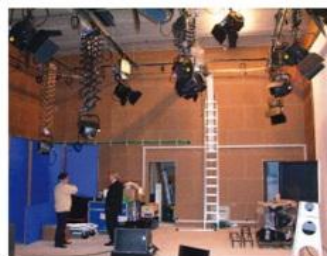
Obr. 7 – Realizace akustických desek
