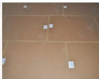
Obr. 6 – Montáž akustických desek WOLF na různé typy konstrukcí
