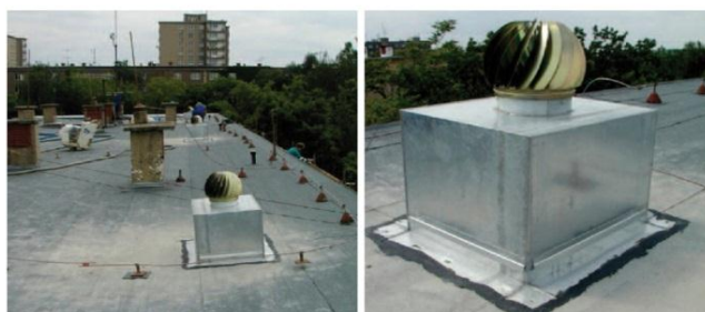
Obr. 2 – Odvětrávání dvouplášťové střechy po aplikaci foukané izolace
