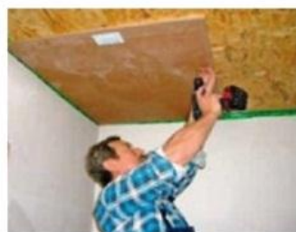
Obr. 6 – Montáž akustických desek WOLF na různé typy konstrukcí
