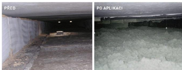
Obr. 1 – Foukaná izolace v konstrukci dvouplášťové střechy
