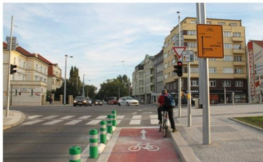
Odstaňování bariér cykloturistiky při přestavbách v území (světelně řízený výjezd z cykloobousměrky Pelléova nad pražským tunelem Blanka). Foto: Tomáš Cach
