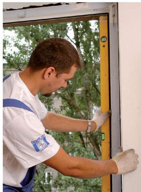
Pro dosažení optimální funkčnosti je vhodné svěřit instalaci oken odborníkům, nejlépe těm certifikovaným.
