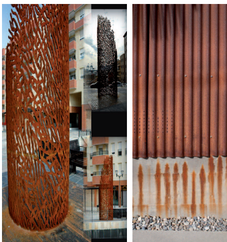
Obr. 2. Výrobky vyrobené z oceli Corten (Atmofix)
