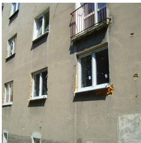
Bytový dům Sokolov, 07/2014.
