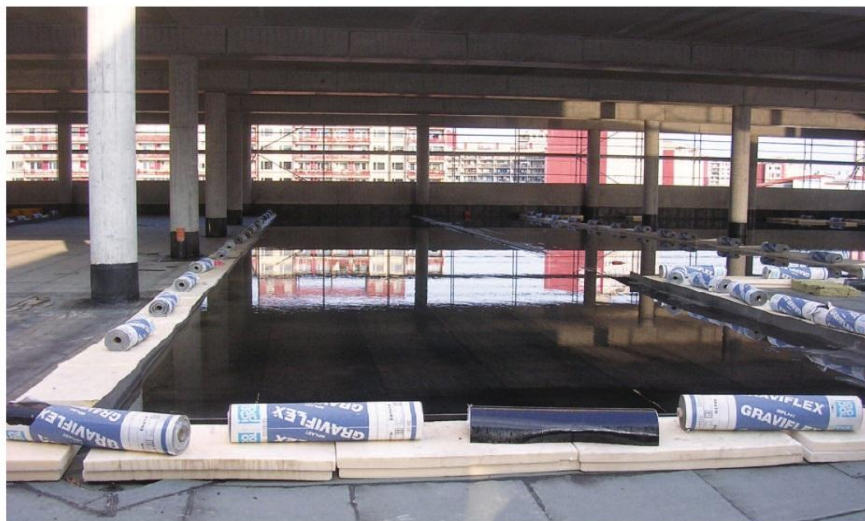
Obr. 1 – Sektorování při zátopových zkouškách
