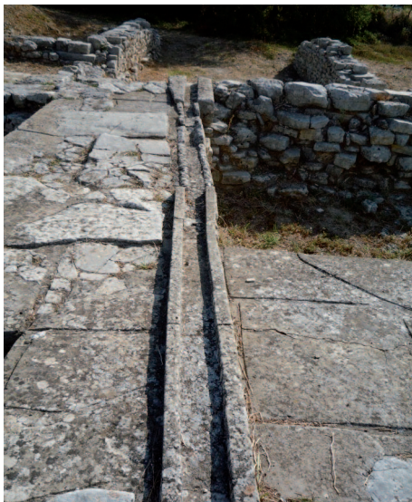
Odvádění dešťových vod do akumulačních nádrží v řeckém Knososu
