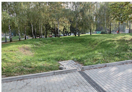
Suchý poldr Brno-Kohoutovice s řízeným odtokem do kanalizace a detail regulačního zařízení Foto: Z. Lhotáková
