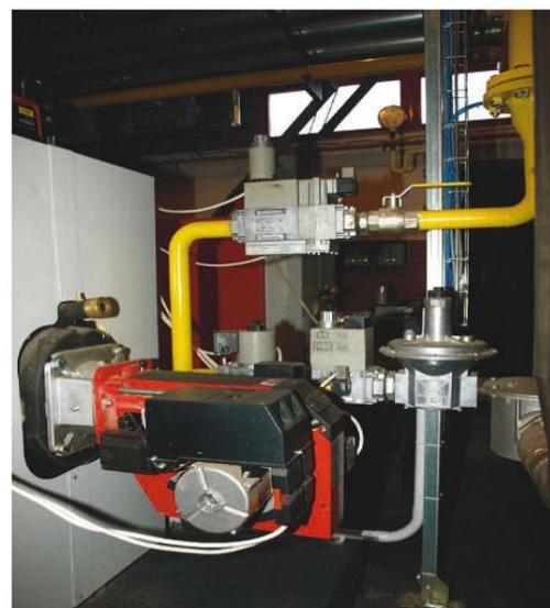
ukázka realizace hořáku na bioplyn s možností přepnutí na palivo zemní plyn
