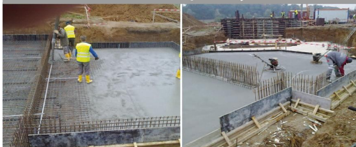
► Úpravy povrchů podlah RD
