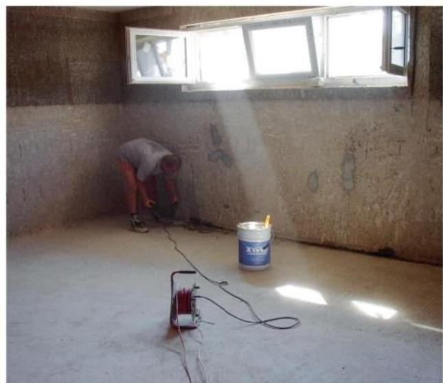
a úspornější řešit izolaci proti vodě i radonu bariérami nanášenými nátěry či nástríky, které jsou bezespárové. U konstrukcí stávajících objektů je obvykle jakékoli opatření proti pronikání vody či radonu prováděn z vnější strany konstrukce technicky natolik komplikované, že nezbývá, než volit provedení izolace zevnitř.
