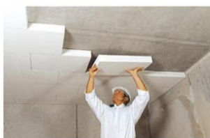
Zateplování podhledů klade vyšší nároky na výborné tepelněizolační vlastnosti materiálu a jeho požární odolnost.
