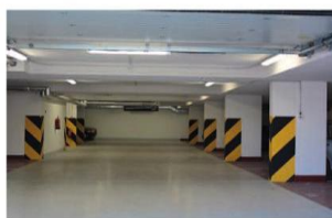
Bytový dům v Dolních Chabrech. Podhledy z tepelněizolačních desek Ytong Multipor dobře působí i bez dodatečné povrchové úpravy.
