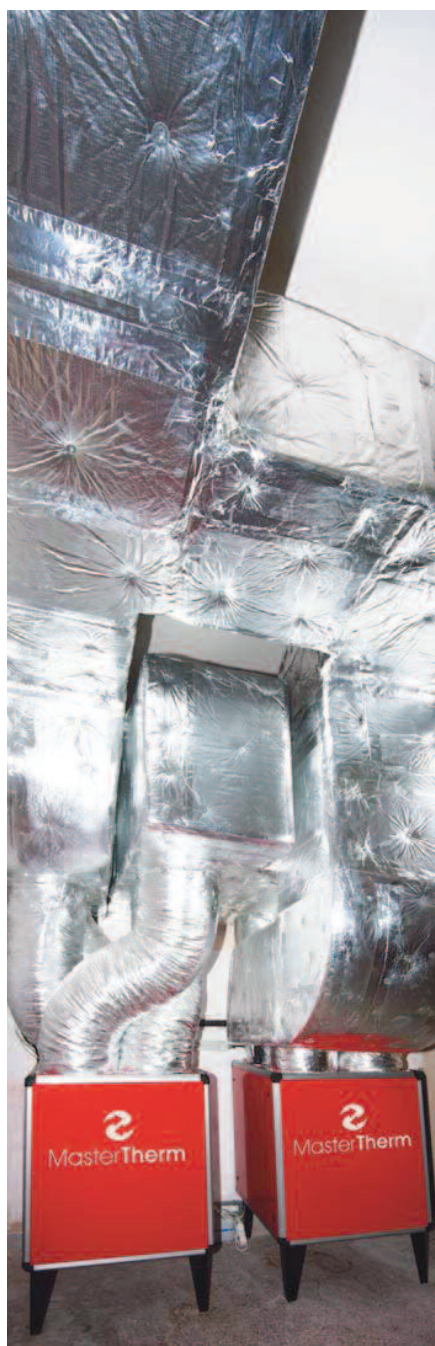
Skříň výparníku, každá o výkonu 30,8 kW A7W35
