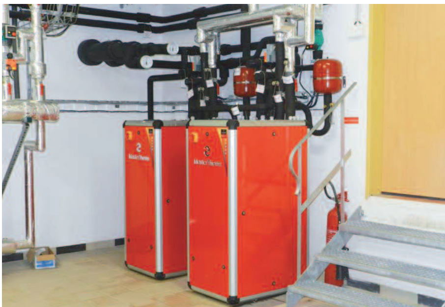
Dvojice kompresorových jednotek (2x30,8kW A7W35)
