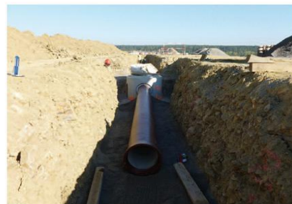
Uložení kanalizačního potrubí
