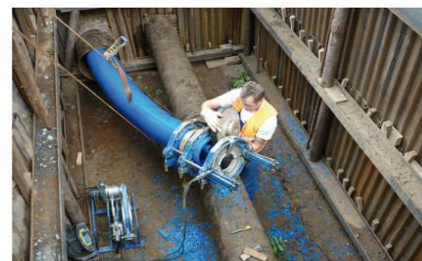
Sanace starého vodovodního potrubí v Praze na Prašném mostě
