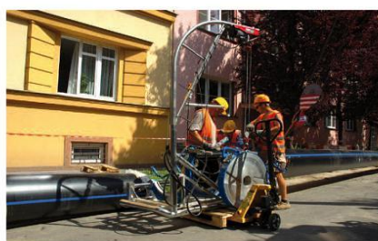
Probíhající sanace vodovodního řadu v ulici Zborovská v Ostravě
