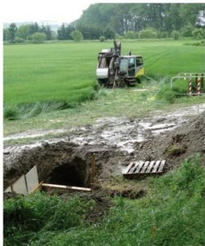
Výstavba nového přívadče vody v Krnově
