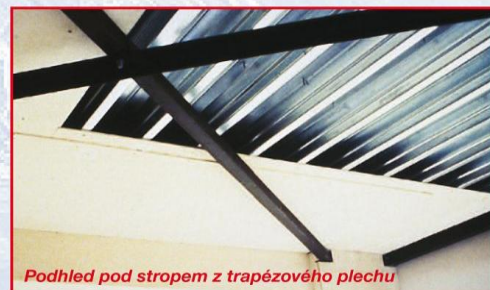
Podhled pod stropem z trapezového plechu
