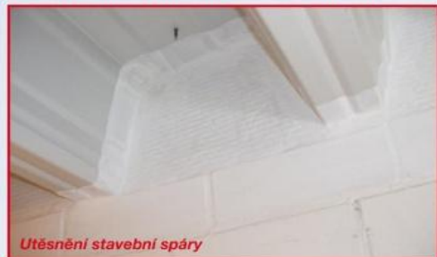
Utěsnění stavební spáry
