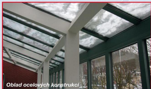
Oblad ocelových konstrukcí
