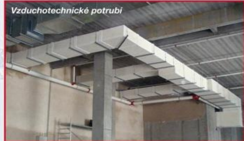
Vzduchotechnické potrubí
