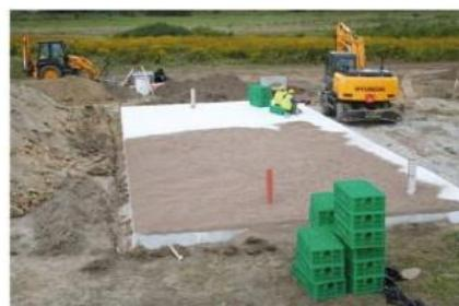
Základním stavebním prvkem systému je vsakovací box o objemu 216 litrů, vyrobený z houževnatého polypropylénu. Výška boxu pouhých 30 cm dovolí použít i v místech s relativně vysokou hladinou podzemní vody.
