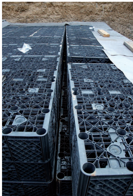
Ukázka nesprávné instalace vsakovacích bloků: špatné spojení bloků, které vzniklo špatně urovnaným podložením. Schod na podloží se promítl i na bloky a spojky, které tak nedrží u sebe.
