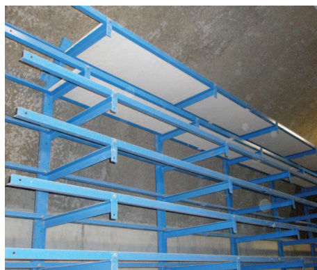
Oddělení kabelových tras deskami PROMATECT-H
