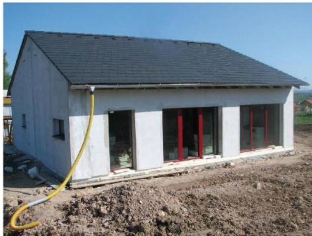
Dokončená hrubá stavba včetně zateplení.
