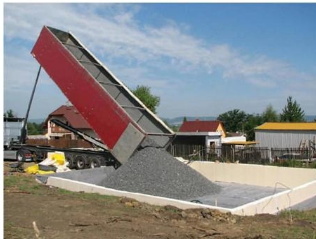
Založení železobetonové desky na drti pěnoscila Technopor.
