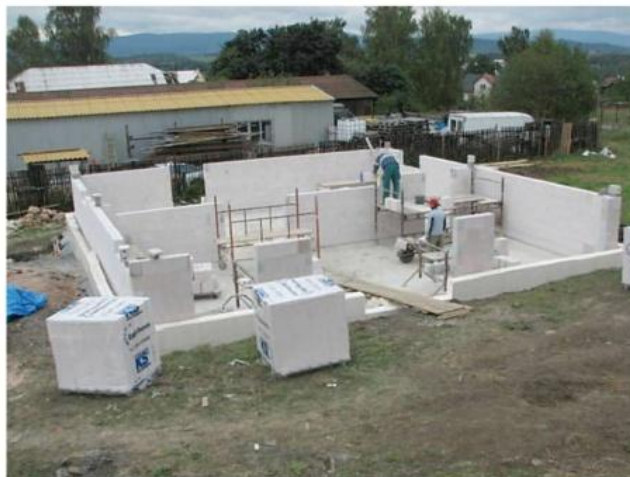
Hrubá stavba z vápenopískových cihel Zapf Daigfuss.
