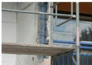
Obr. 5 – Oprava odpadlé krycí vrstvy
