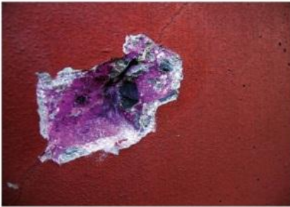
Obr. 3 – Zkouška vývrtu betonové konstrukce fenoltaleinem
