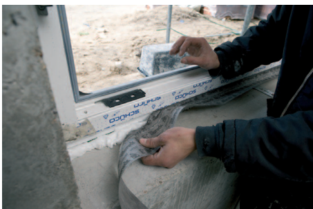
Membrány musí být zvenku paropropustné a zevnitř parotěsné. Místo nich mohou být použity inteligentní membrány s variabilní propustností vlhkosti, např. TwinAktiv
