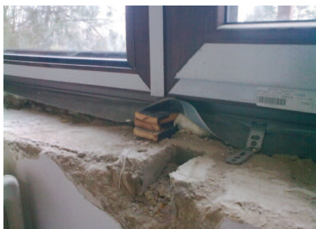
Obr. č. 3 Podkladní dřevěný špalek – okno s parozábranou
