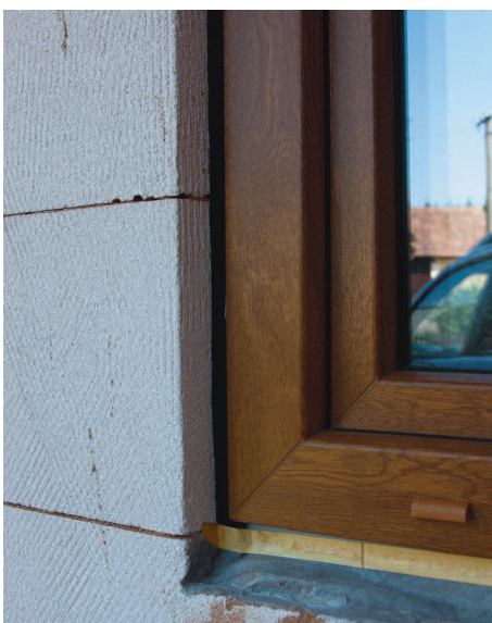
Komprimované pásky, např. illmod Trio+, nahrazují systém utěsnění připojovací spáry s membránami a PUR pěnou. Pásky poskytují interiérové a exteriérové utěsnění s vnitřní tepelnou izolací. Jsou navíc UV stabilní.
