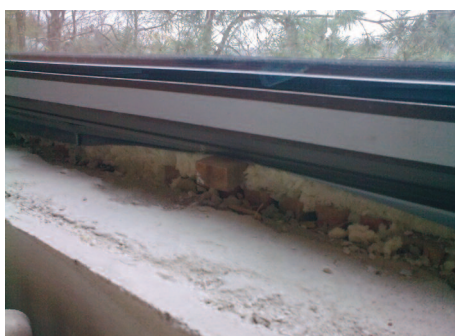
Obr. č. 2 Podkladní dřevěný špalek – okno s parozábranou
