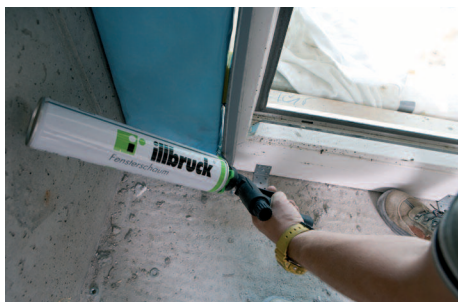
Plnicí pěna plní pouze funkci tepelného izolantu a nesmí být použita jako jediný uzavírací materiál.
