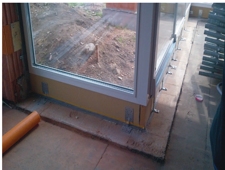
Obr. č. 7 Osazení a kotvení Purenit sendviče u podlahy
