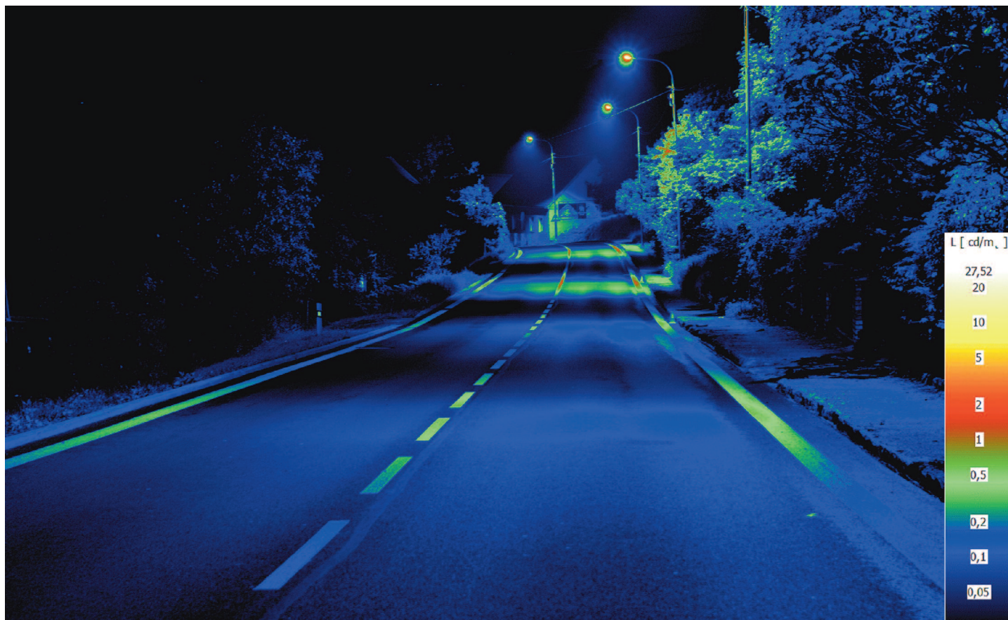
Obr. 1 - Kvalitu osvětlení ukáže nejnázorněji jasová kamera. Dodavatelská společnost K tvrdí, že osvětlení v obci Ž vyhovuje třídě osvětlení ME6. Není tomu tak. Průměrný jas je sotva 0,1 \text{ cd}\cdot\text{m}^{-2} (má být 0,3), nedostatečná je podélná 0,1 i celková rovnoměrnost 0,13 (mají být alespoň 0,4 a 0,35). Zdroj: archiv IRMO
