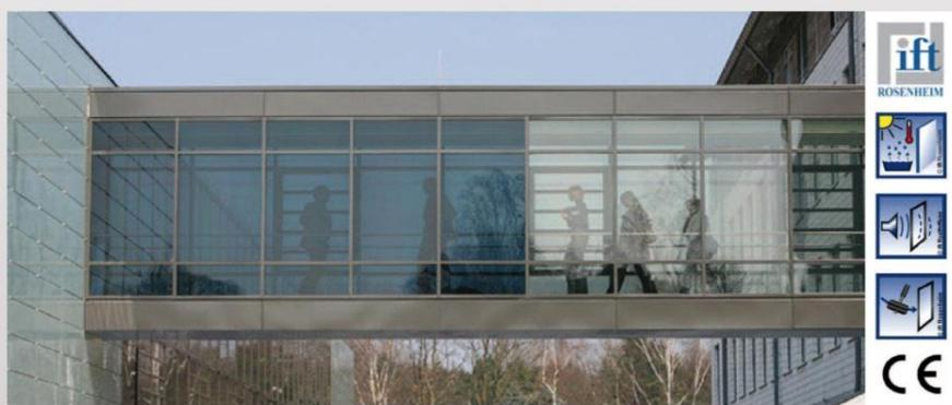
Tyto vrstvy mají jednu společnou vlastnost, čím více naneseme kovů na povrch skla, tím méně nám projde světla do interiéru, tím menší jsou tepelné ztráty a rovněž i zisk od slunce do interiéru.
