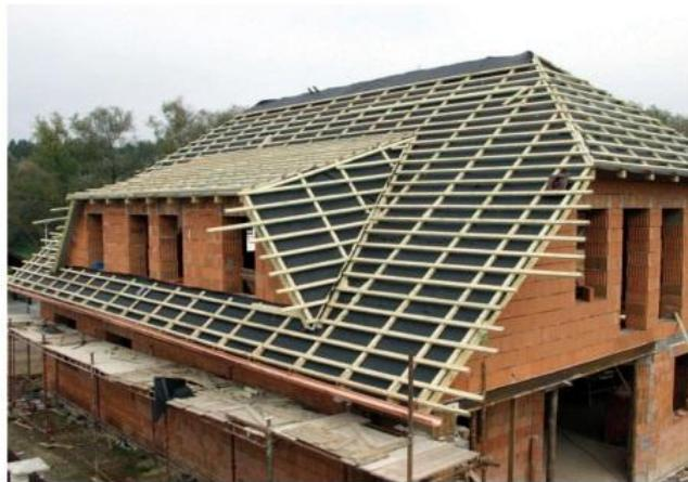
a to jak na druh a těsnost skládané krytiny (upravení stanoveného bezpečného sklonu), tak i na vhodný výběr doplňkové hydroizolace (podstřešní fólie). Pokud se podíváme na novou výstavbu, zejména ve vazbě na nízkoenergetické či pasivní stavby, vidíme stále častěji snižování sklonů střech se skládají střešní krytinou a podkročením jejího bezpečného sklonu.
