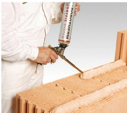
S pomocí zdicí pěny POROTHERM DRYFIX lze zvládnout hrubou stavbu běžného rodinného domu na už hotové základové desce do týdne. Ve srovnání s klasickým
